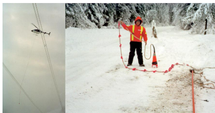
شکل ۳- استفاده از هلی کوپتر برای یخ‌زدایی با استفاده از وزنه ۹۰ کیلوگرمی و طناب بلند
